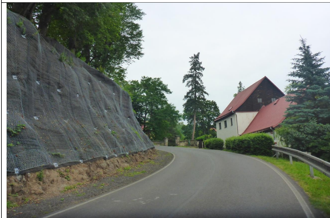
Sítí zpevněná skála nad ulicí Husova. Touto úpravou došlo k rozšíření prostoru u krajnice vozovky.
