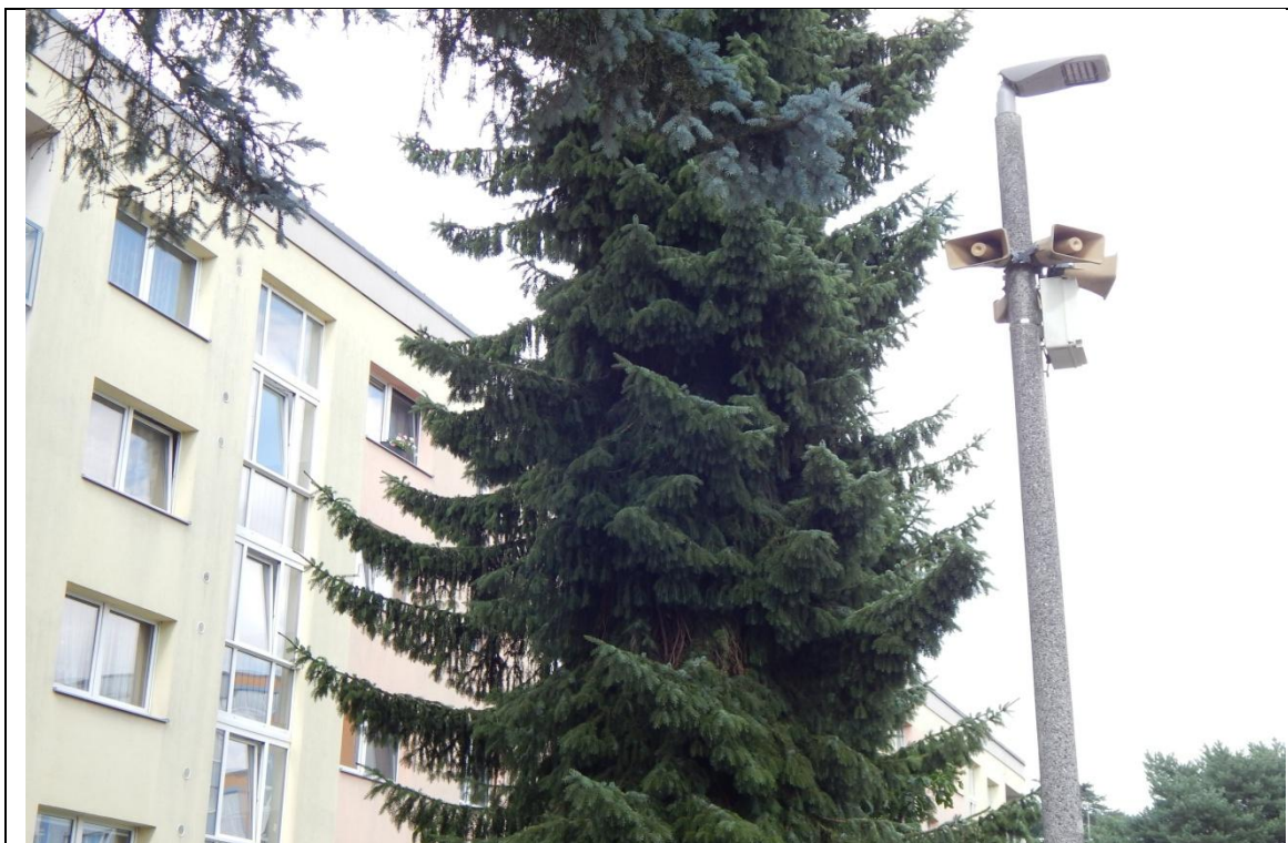
Jeden ze 74 hlásičů městského bezdrátového rozhlasu. Tento je osazen čtyřmi reproduktory.
