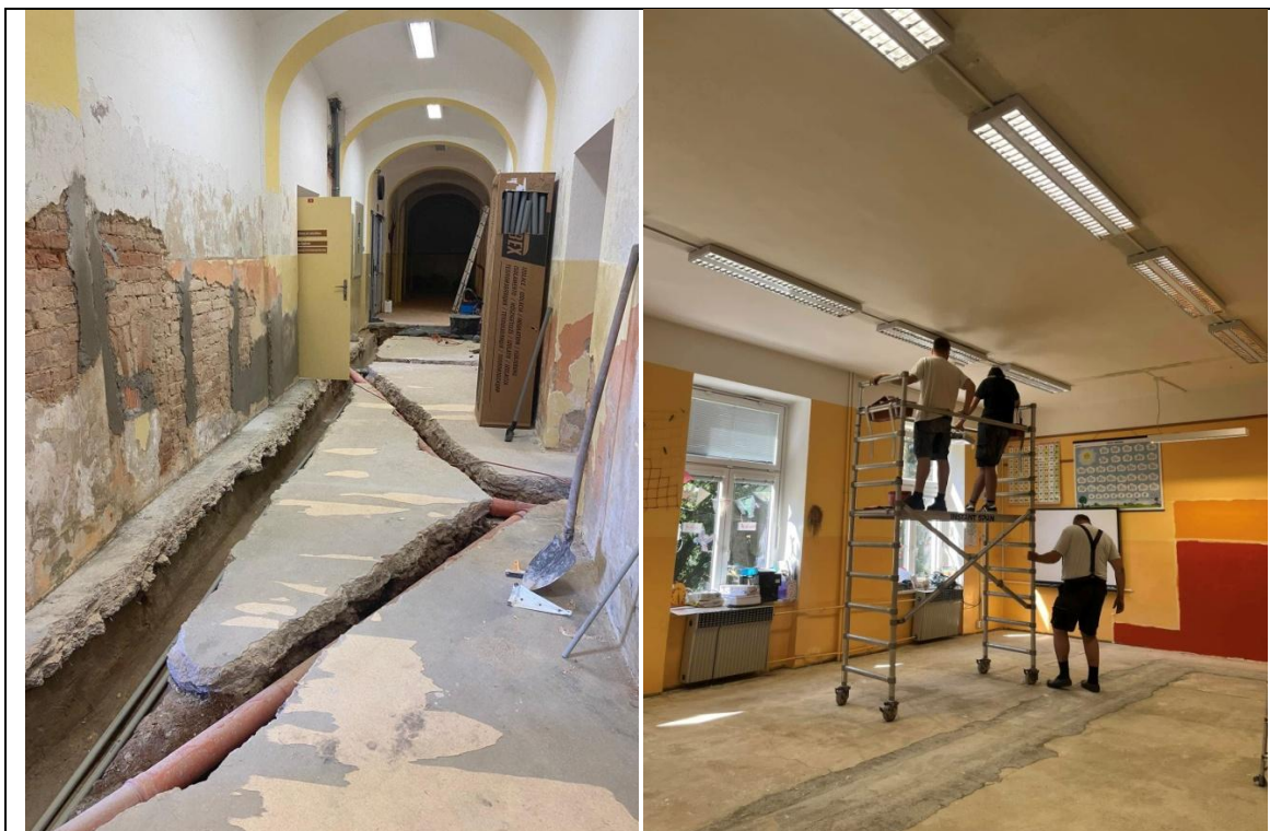
Během letních prázdnin proběhla rekonstrukce učeben v „Bílé škole“ a výměna původních instalačních rozvodů ze 70. let.
