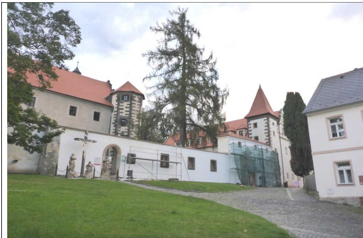
Vzhled náměstí pozdvihla oprava omítek ohradní zdi areálu Horního zámku.
