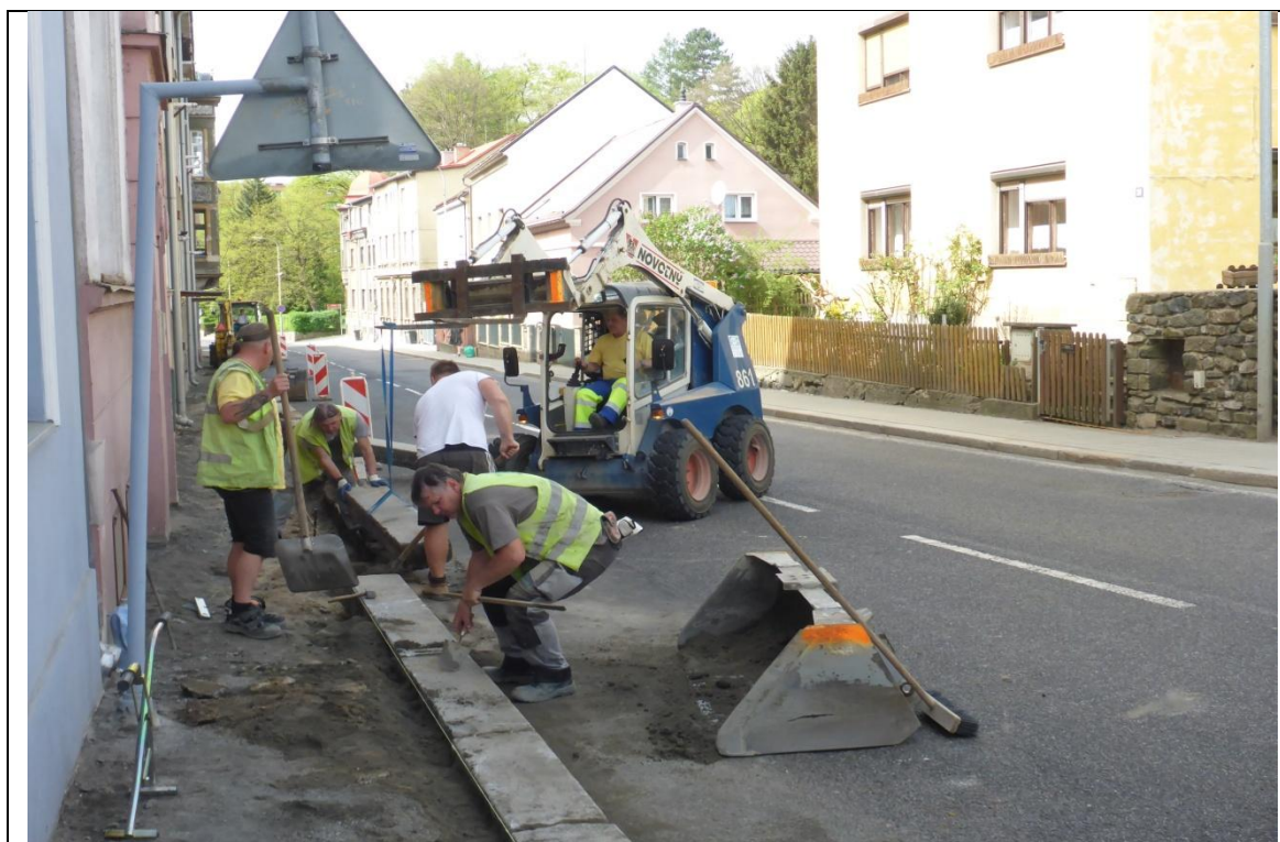
Opětovné usazení původních žulových obrubníků na Děčínské ulici. Duben 2024.
