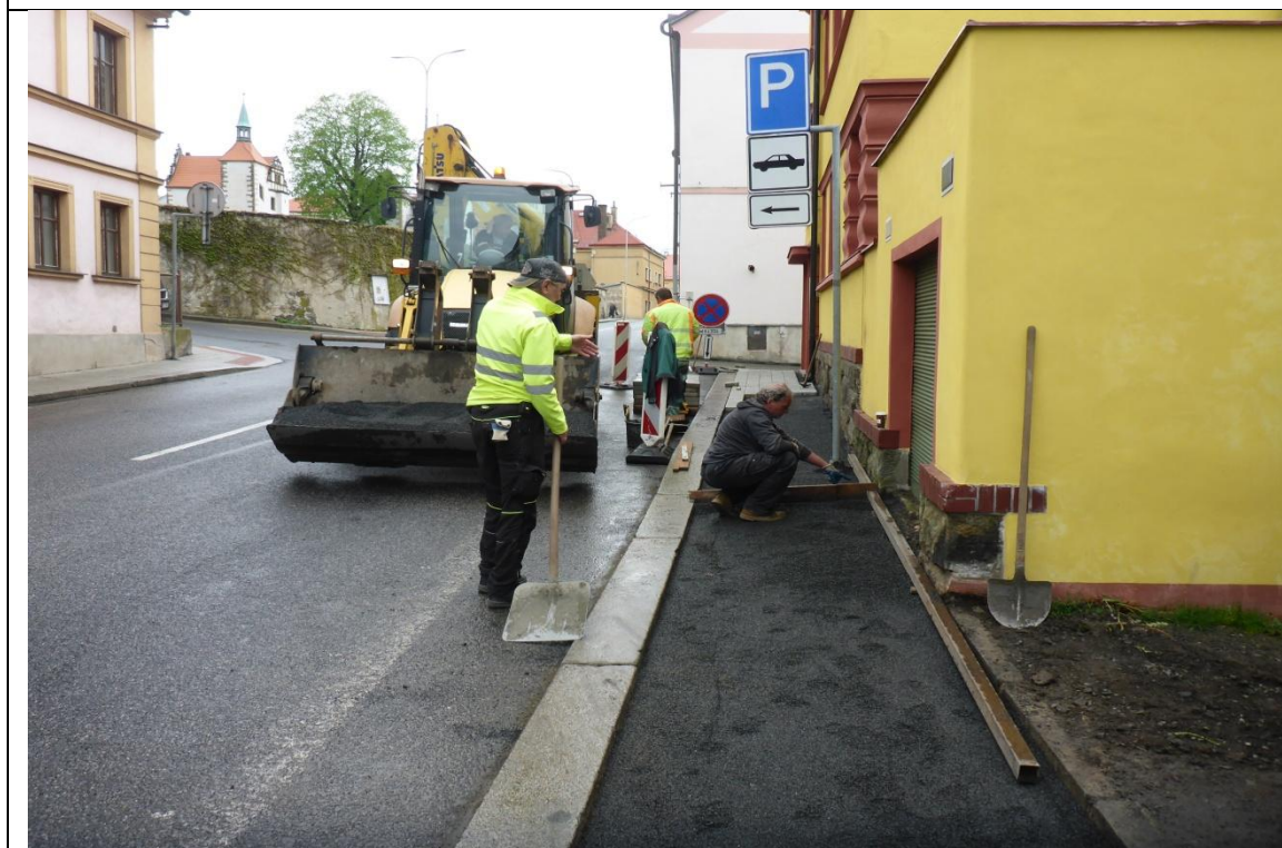
Na začátku dubna byl předlážděn chodník na jedné straně horní části Děčínské ulice.
