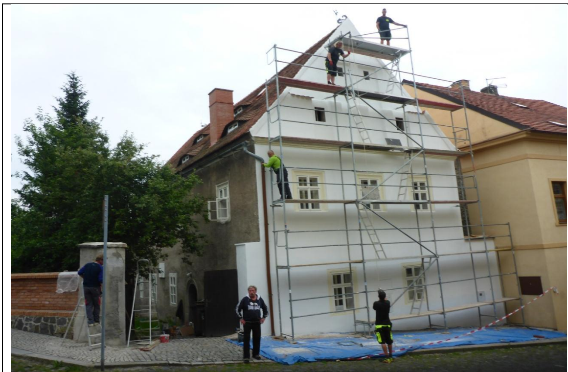
Oprava čelní fasády domu čp. 71 v Kostelní ulici podpořená dotačním programem Regenerace městské památkové zóny.
