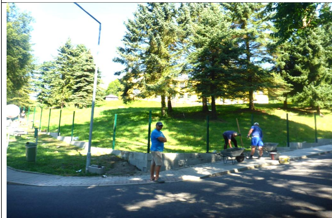
Původní 60 let starý plot byl nahrazen novým plotem se ztraceným bedněním, podhrabníky a svařovaným pletivem.
