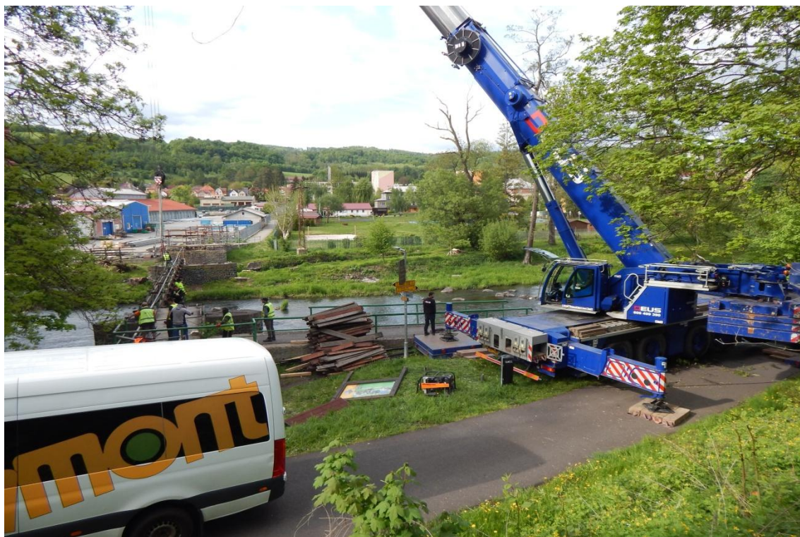
Jeřábnické práce provedla pro stavbu realizující firmu Viamont se svým jeřábem LIEBHERR o nosnosti 200 tun varnsdorfská firma DEUS.
