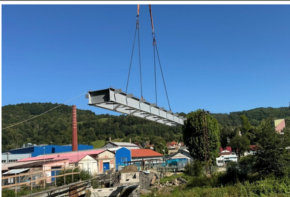
18.srpna dělníci instalovali přes řeku nové prvky konstrukce lávky. Foto : web města.
