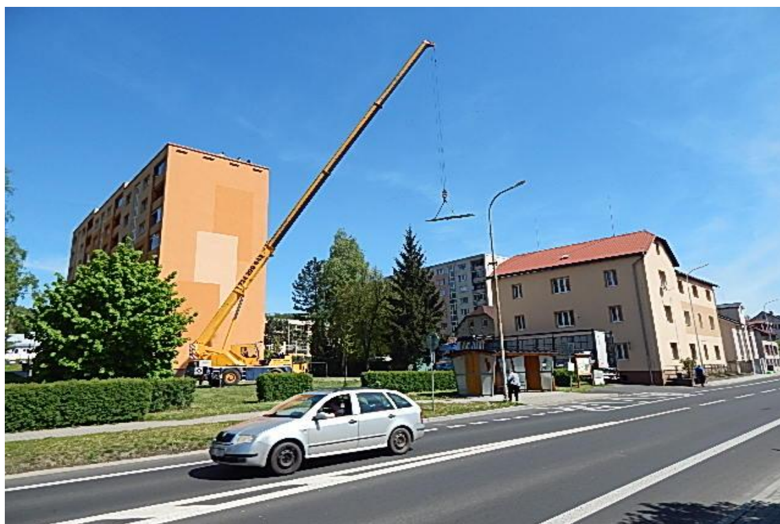
Obyvatelé vysokého panelového domu se rozhodli nahradit plochou střechu za sedlovou. Záběr na zvedání prvků jeřábem.
