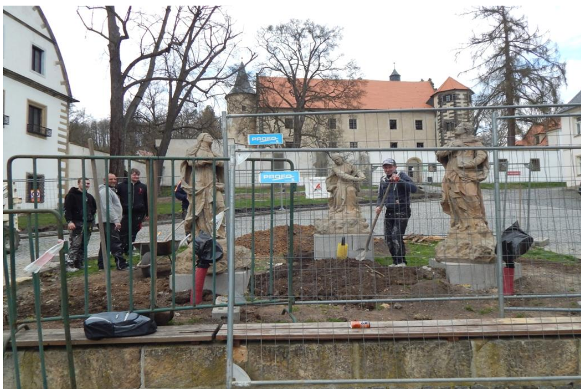
Pracovníci Děčínského stavebního podniku při úpravě okolí soch na jejich novém místě.
