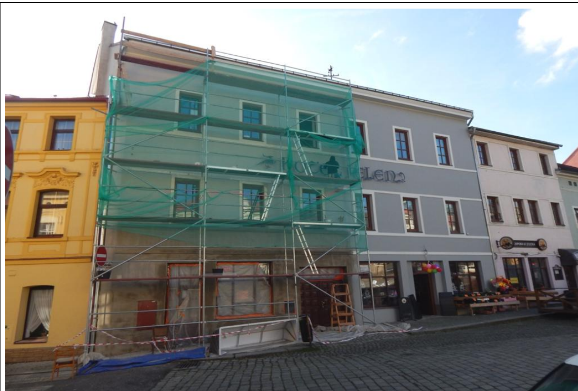
Na podzim se dočkala na náměstí Míru budova čp. 10 nové fasády.
