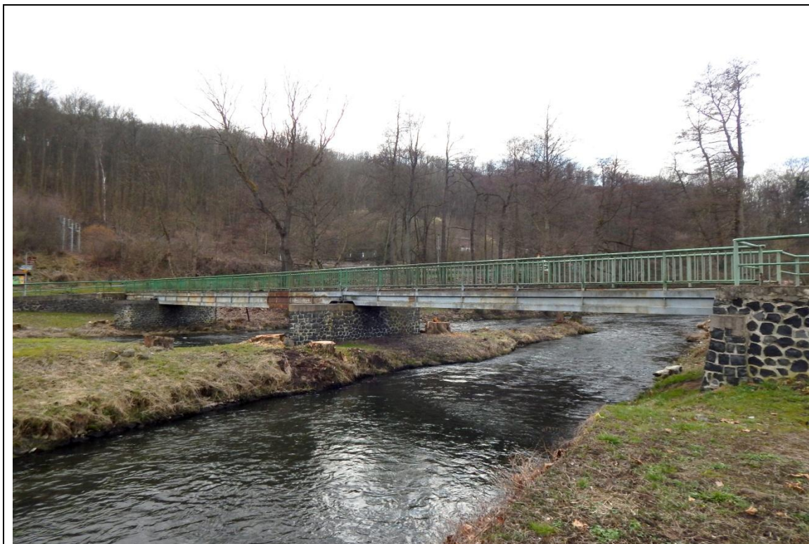
Záběr na lávku přes Ploučnici spojující Nádražní ulici s Děčínskou před zahájením její výměny.
