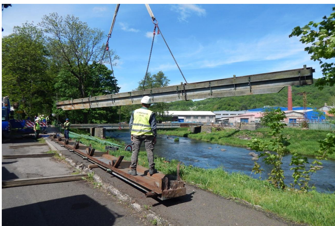
29. dubna byly demontovány hlavní nosníky lávky přes Ploučnici spojující Nádražní ulici s Děčínskou.
