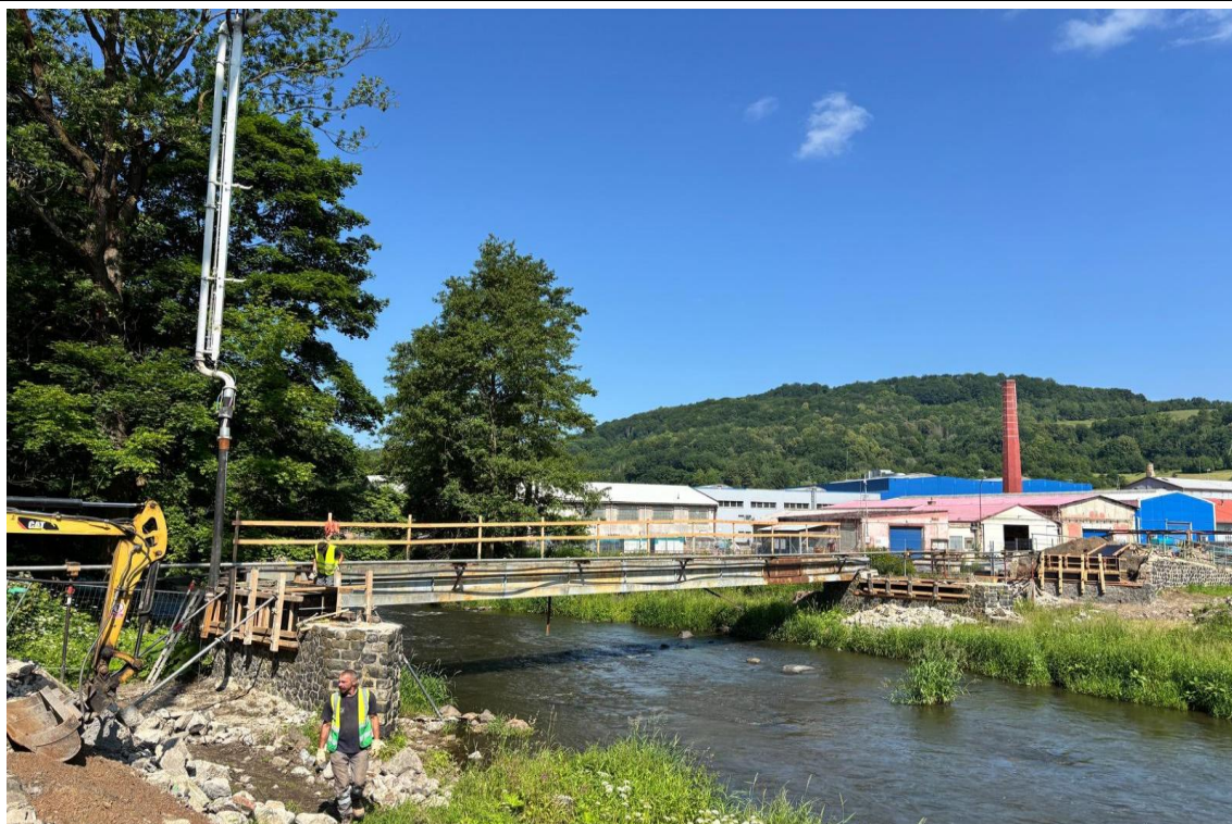
12.června proběhla na stavbě lávky sanace stávajících pilířů novou betonáží.
